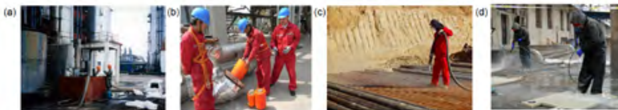
图2 (a) 化学清洗;(b) PIG 清洗;(c) 喷砂清洗;(d) 高压水射流清洗 [12]
