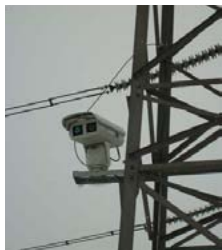
机器在电力部门实际安装的图片
