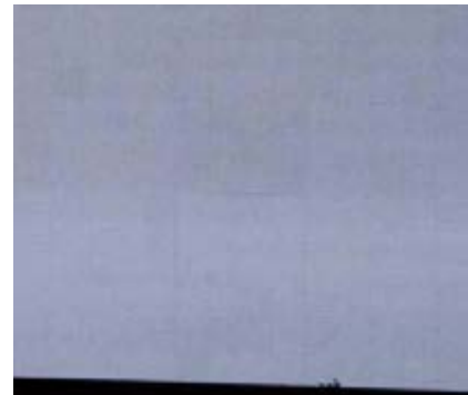
箱体拼装间隙导致以箱体为单位的明暗线
