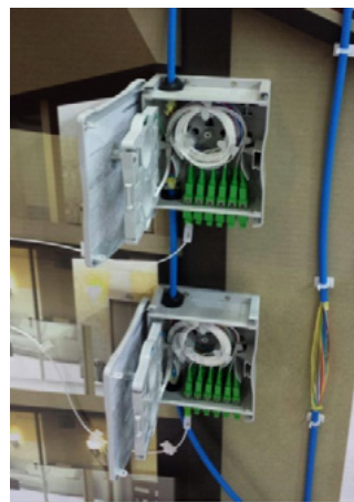
图2 Module 单元分支光缆应用场景
